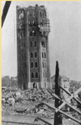
倒壊した東京・浅草の十二階【時事通信社】
